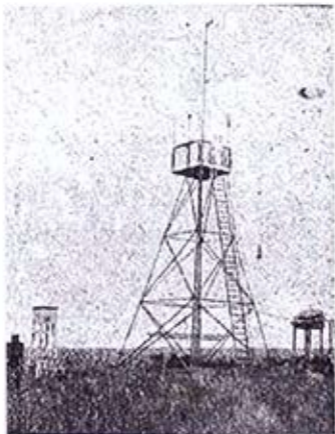
Torre metálica, imagen extraída de Revista CyC N° 226
