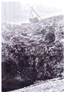
Plataforma de carga desde la barranca
