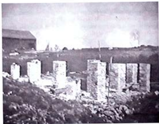
Pilares de los instrumentos magnéticos del observatorio en construcción
