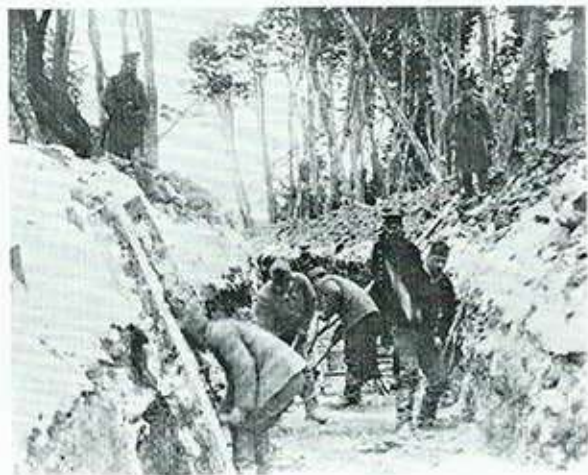
Preparando el terraplén del tren durante el invierno.
