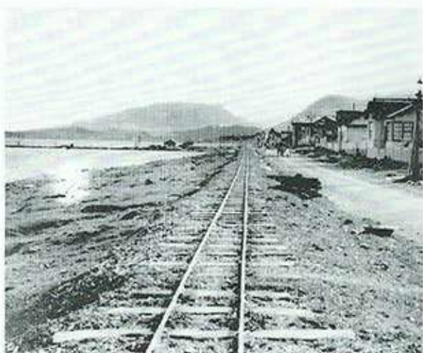
Tendido de la vía en la actual calle Maipú.
