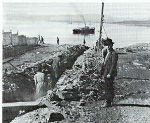
Instalación de red de agua.
