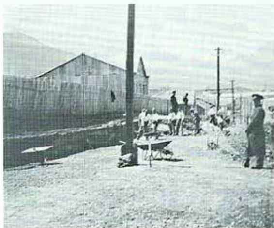
Trabajos en la actual calle San Martín bajo la vigilancia de guardiacárceles.
