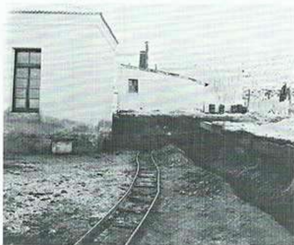
Las vías para las vagonetas se extendían a todo lugar donde se trabajase.
